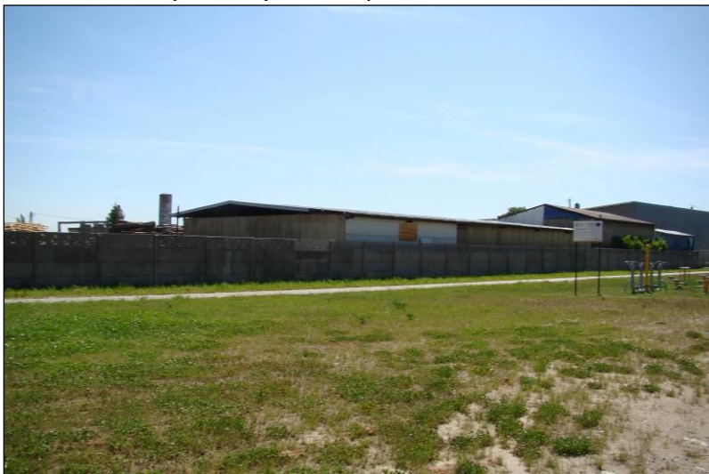
Fot. 6 Widok od strony zachodniej w kierunku południowo-wschodnim
