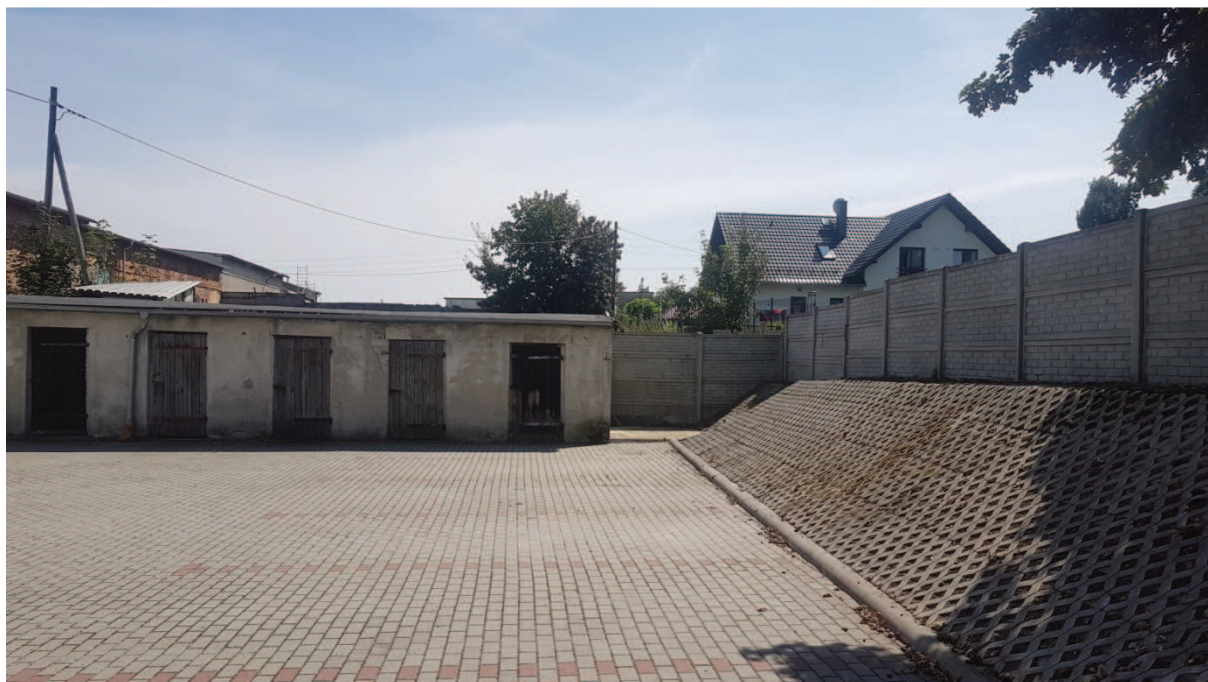
ogrodzenie od strony zachodniej
