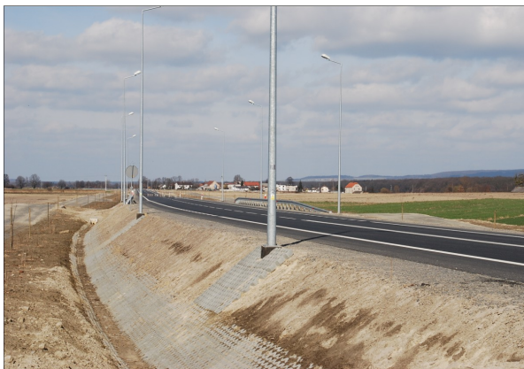
Fot. 10. Odcinek obwodnicy Poborszowa – droga krajowe nr 45. Przykład nowej inwestycji zmniejszającej uciążliwość ruchu drogowego w obszarach zabudowanych.
