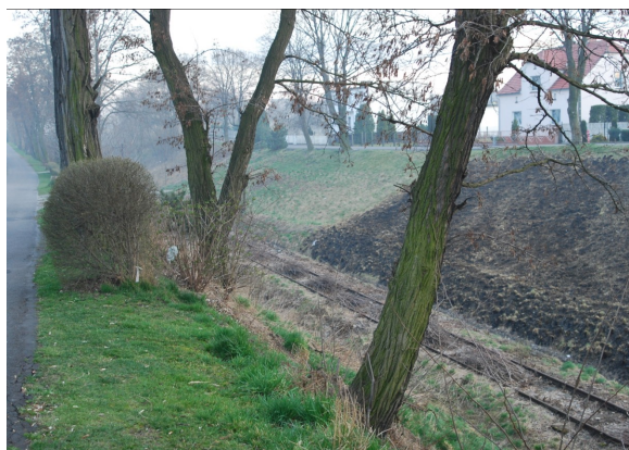
Fot. 2. Charakterystyczne położenie linii kolejowej na terenie wsi Reńska Wieś
