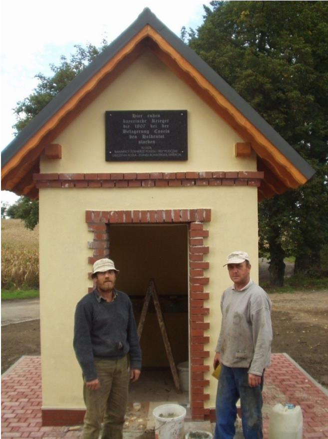
Zdjęcie 2 Kapliczka Napoleńska w trakcie remontu
